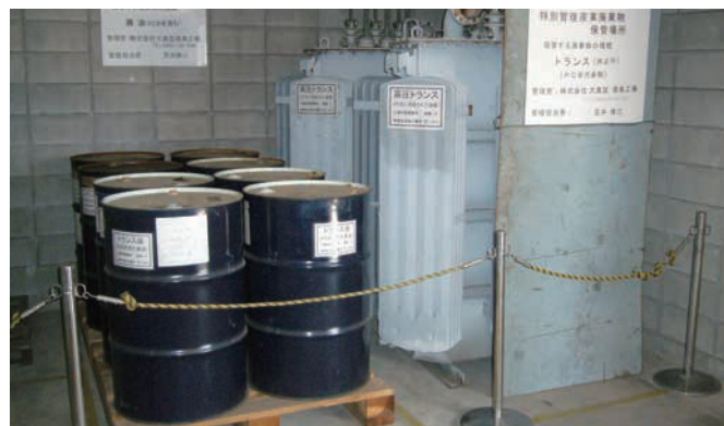
PCB廃棄物保管状況
