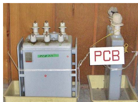
PCB廃棄物保管状況
