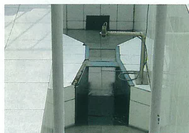
放流水監視槽
