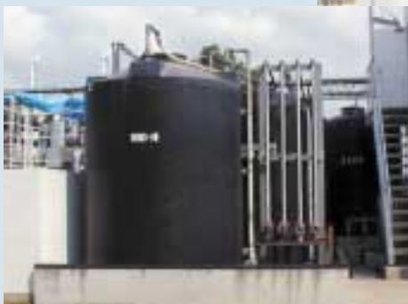
排水処理施設全景
