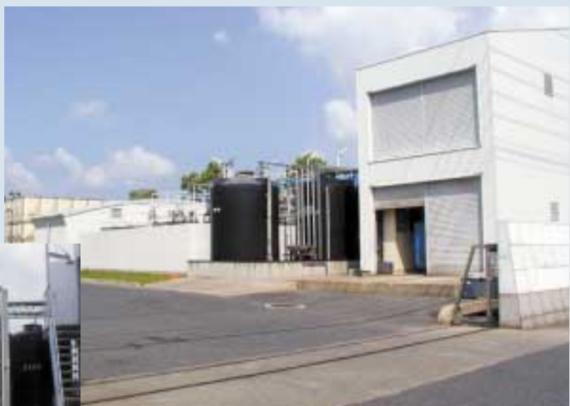
薬品タンクと防液堤
