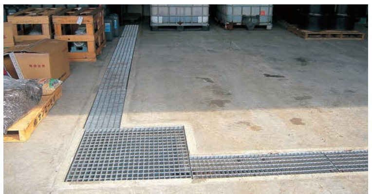
徳島事業所 廃液漏洩時の外部流出防止マス
