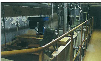
廃水処置施設
